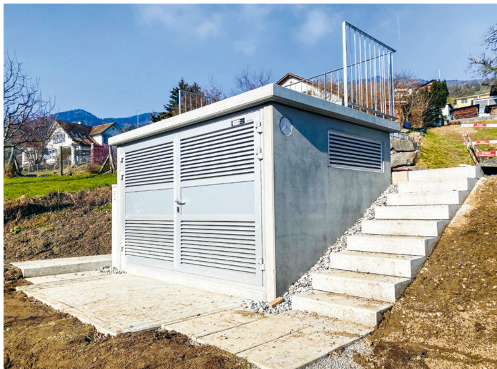
Neubau Trafostation Bergstrasse
